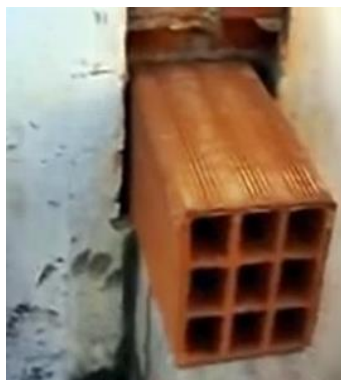
Amarração entre alvenaria nova e existente
