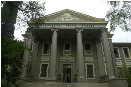
Fachada do prédio principal do IPA
