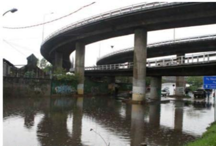
Foto 8: Alagamento registrado no cruzamento da Av. Sertório com Av. Voluntários da Pátria, bairro Marclio Dias, sob as alças de acesso à ponte do lago Guaíba no dia 18 de setembro de 2012. Fonte: Jornal do Comércio, 2013.
